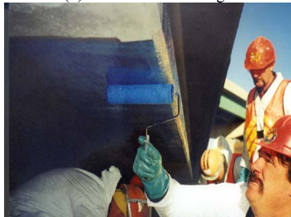
(d) Application of Saturant
