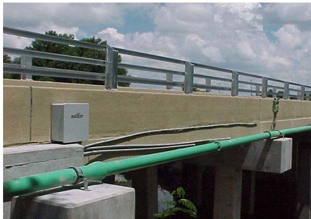
(b) DMI and utility conduits
