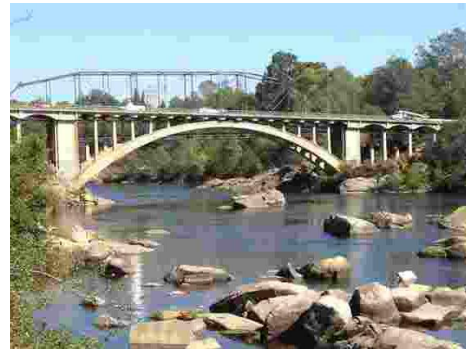
(d) Bridge Pier Scour Protection
