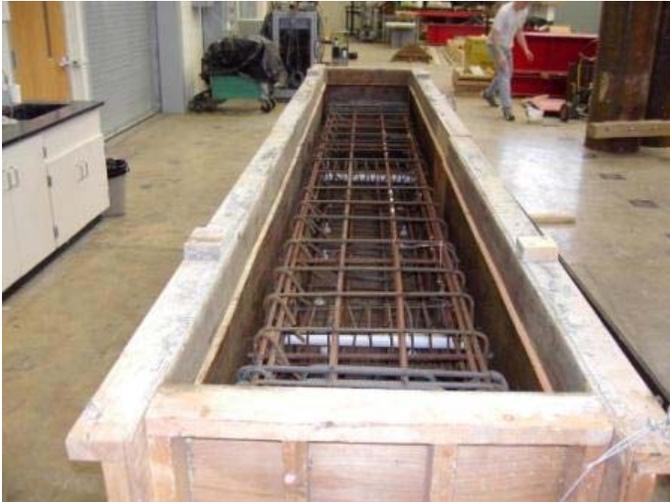
**Figure 0-14. Bent Cap Inside Form Work**
