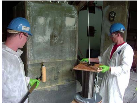
(d) Second coat of saturant
