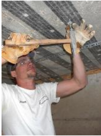
b) Bolt Hammering
