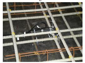
b.) HS-SCC GFRP VWSG Arrangement
