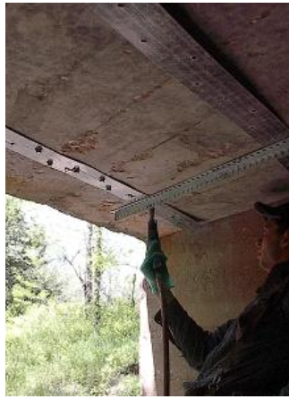
b) Bolt Hammering
