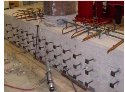
(d) Installation of Headed Bars
